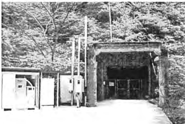
尾小屋トンネル入り口
