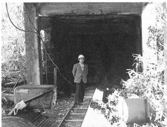
地下測定室建設を計画している尾小屋鉱山 第三トンネル入り口付近
