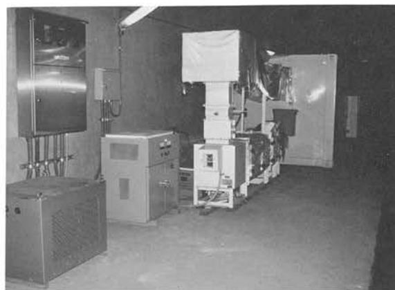
御母衣ダム地下トンネル内の極低バックグラウンド放射能測定用設備(LLRL-AR-8, p.7 参照)と本年度の設置の無停電電源用装置(手前中央)
