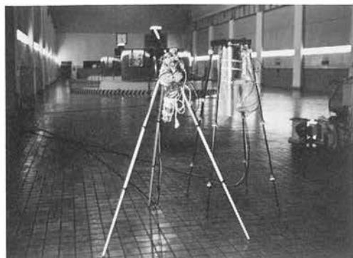
御母衣ダム発電所(地下240m) 内での測定 ----- p.4 参照
