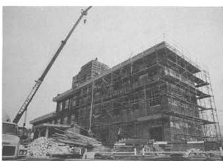
躯体完了(4月24日)
