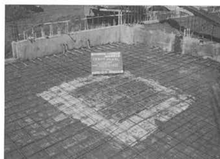
土間配筋(3月5日)
