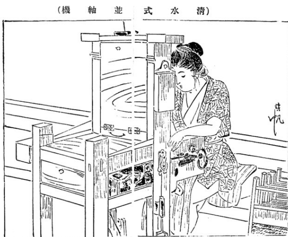
図5-1 清水式並軸機 (石井, 1903b).
