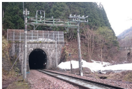
1931 年 9 月開通した清水トンネル (川崎康成「雪国」に登場する)
