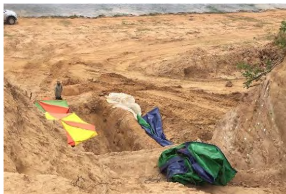
写真3. 堤防の修復現場
