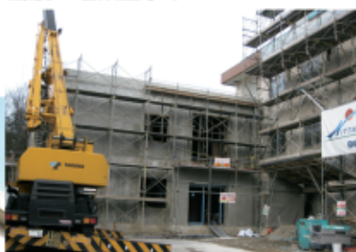
2013/8-2014/3 耐震・増築工事中
